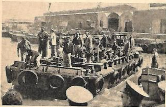
דוברת-הברזל — שי החבל הימי לישראל לנמל תל-אביב. ארכה — 15½ מ', רחבה — 5 מ', משקלה — 22 טון וכח קיבולה — 50 טון.
